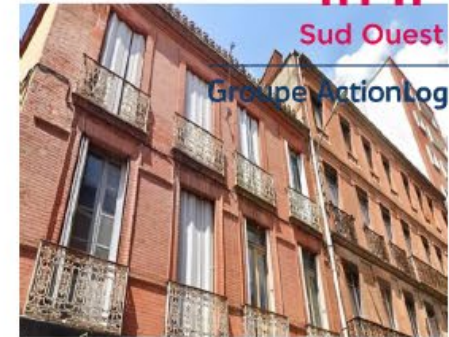
REHABILITATION LOGEMENT RUE DENFERT ROCHEREAU
